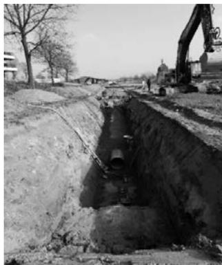
Die bestehende Hauptabwasserleitung konnte bei starken Regenfällen nicht alles Wasser abführen und es bildete sich jeweils ein Rückstau. Dies führte zu überfluteten Kellern im Gebiet Gäälimatt, Waldig und Fang. Mit der neuen Entlastungsleitung wird die Hauptabwasserleitung entlastet und ein Rückstau verhindert.
